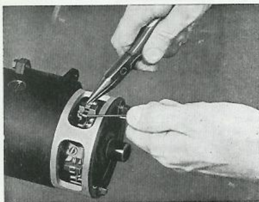
Bild 78. Demontering av elborstar, tid. utf.
